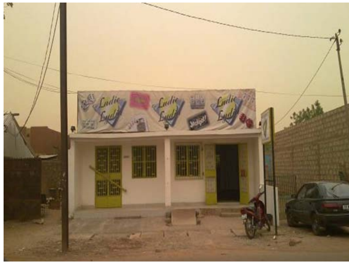
Mini-salon Cyclope 1 après la rénovation
